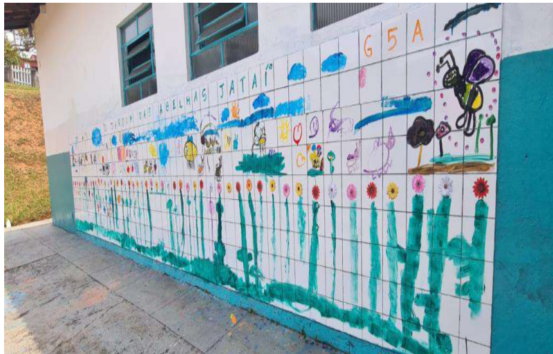
FIGURA 3 – Parede de Azulejos
